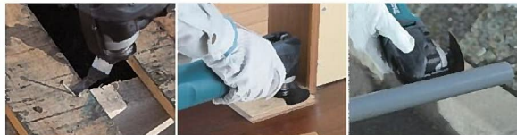
釘の切断 仕上げ材の切断(床材締め) 塩ビ管の切断
